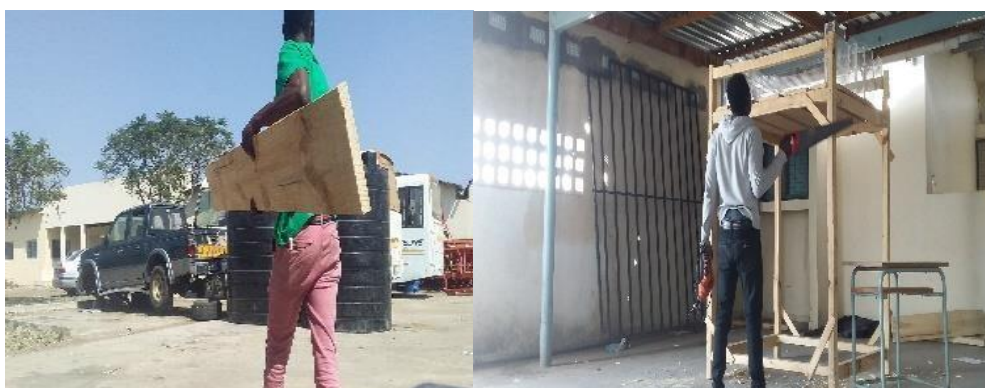
Figura 28: Construção das bancadas das unidades de tratamento
