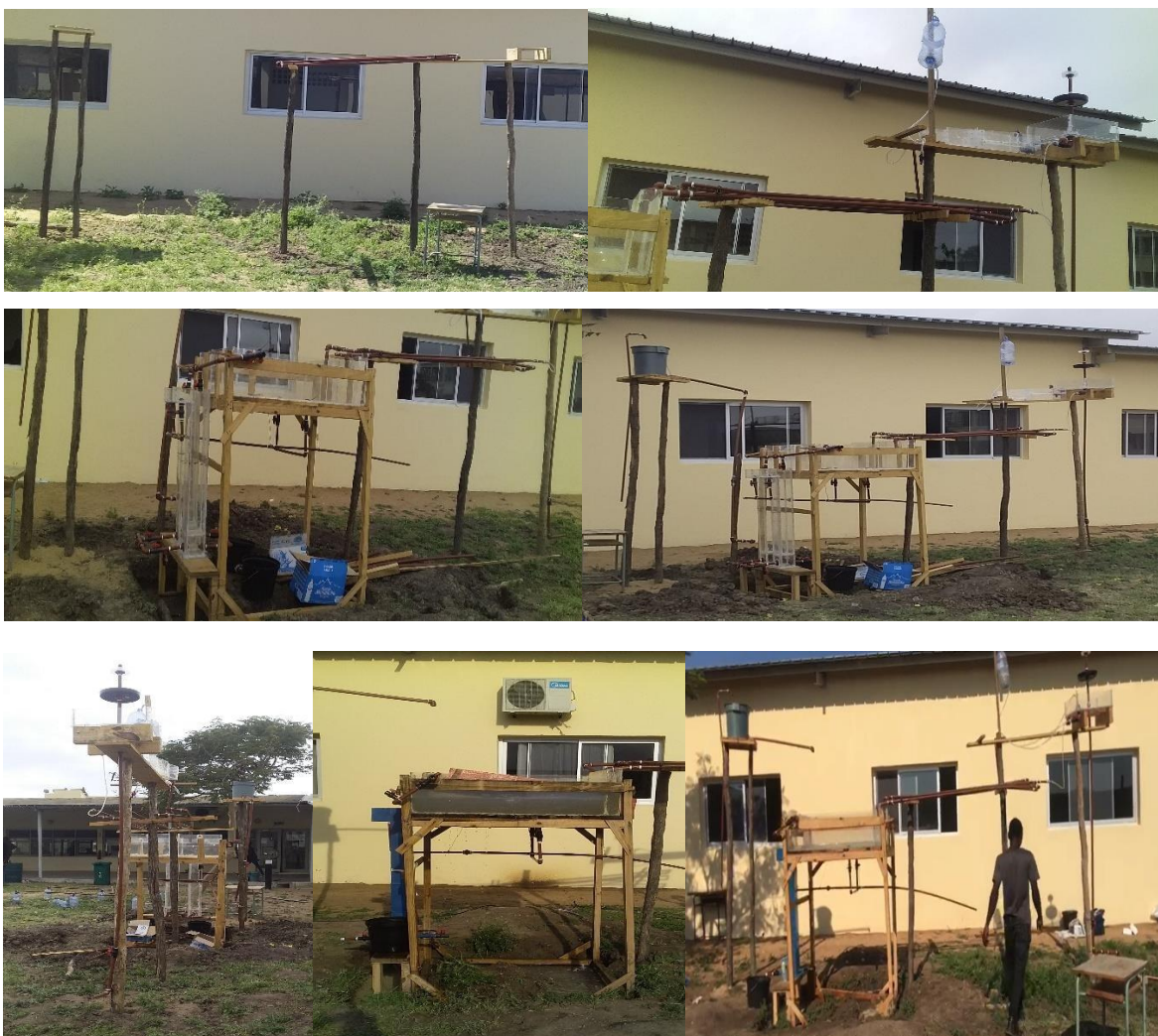
Figura 31: Processo de instalação do sistema
