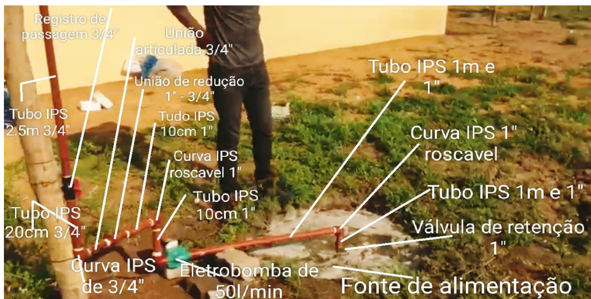
Figura 11: Eletrobomba e os acessórios instalados na fonte de captação
