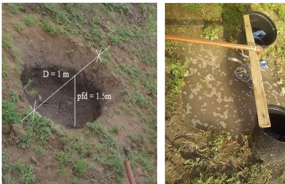
Figura 10: Reservatório escavado usado como fonte de alimentação
