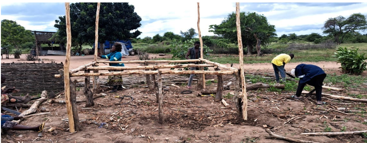
Figura 6: A figura representa os pilares da base do curral.
