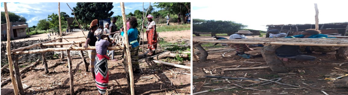
Figura 7: Representa a construção da base
