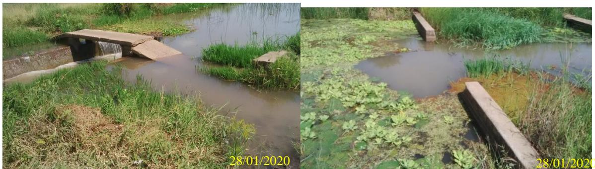
Figure 5: Hidrotubador 15 em estado avançado de degradação
