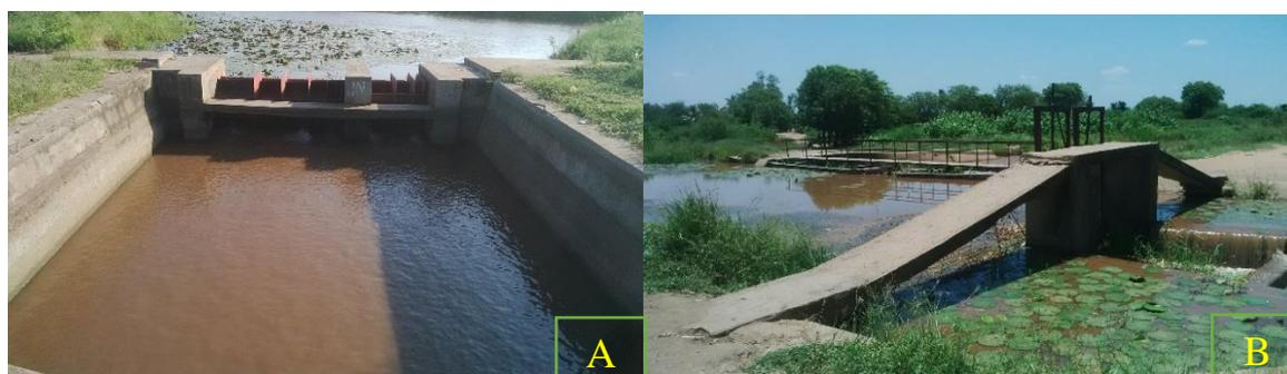
Figure 1: O “A” mostra a tomada de água no regadio novo e “B o canal Direito "B"
