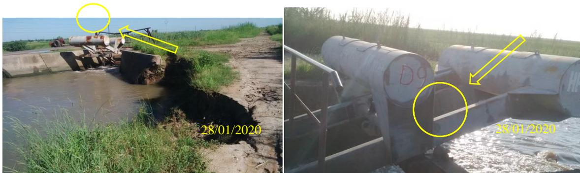
Figure 4: Erosão na margem Direita do canal e Hidrotubos suportado pela pedra
