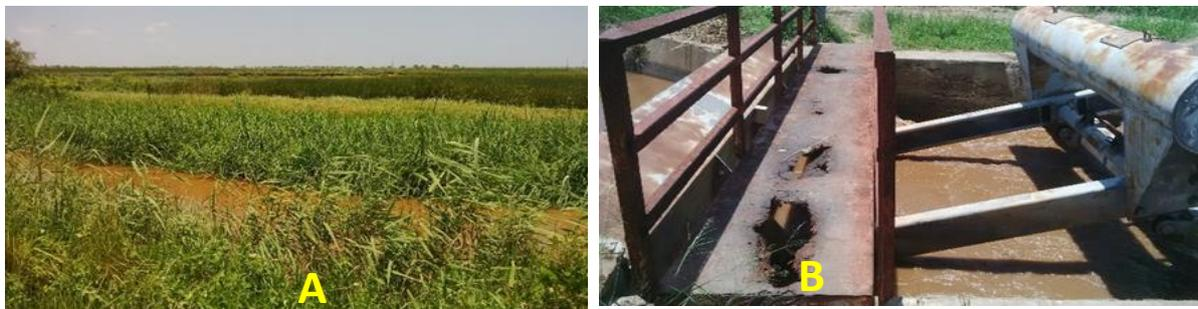
Figure 2:Canal semi-coberto de vegetação A" Hidroregulador no estado obsoleto"B"
