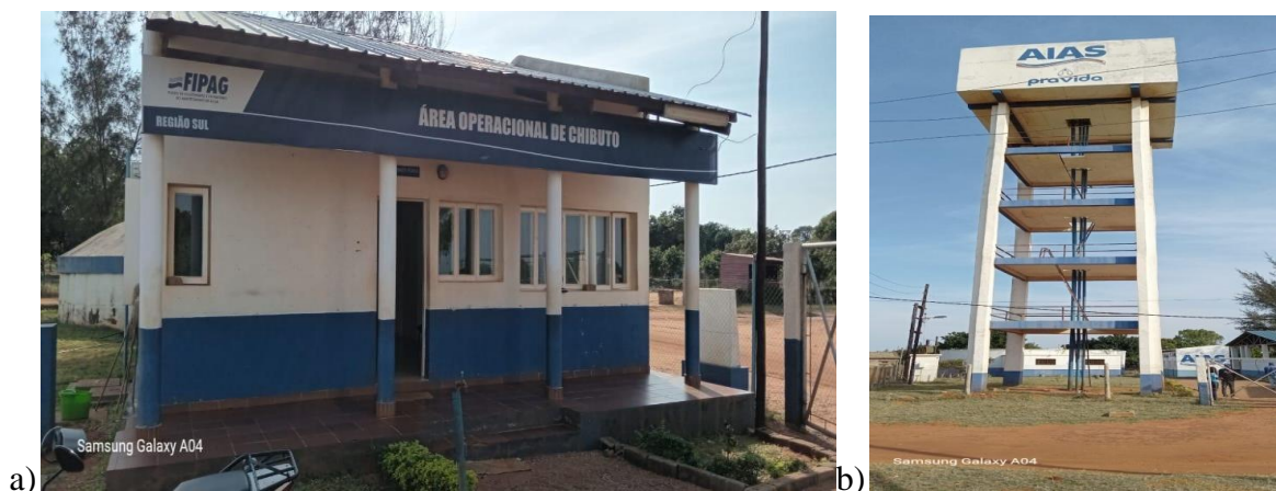
Figura 4- a) Laboratório de análise e qualidade de água; b) Estação de tratamento e reservação do sistema de distribuição de água de Chibuto.
