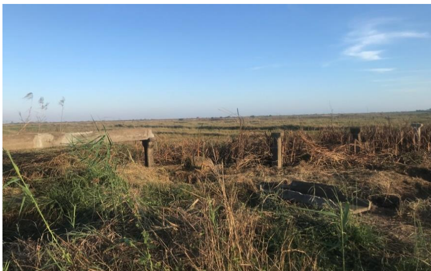
Figura 2: Regadeira degradada na zona 1 (Canal terciário do Distribuidor 7A)
