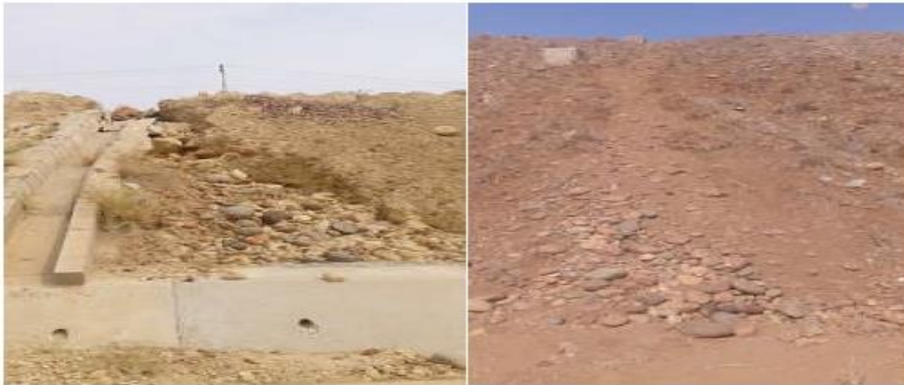
Anexo 8- aparecimento de arbustos e falta de escadas para acesso aos instrumentos
