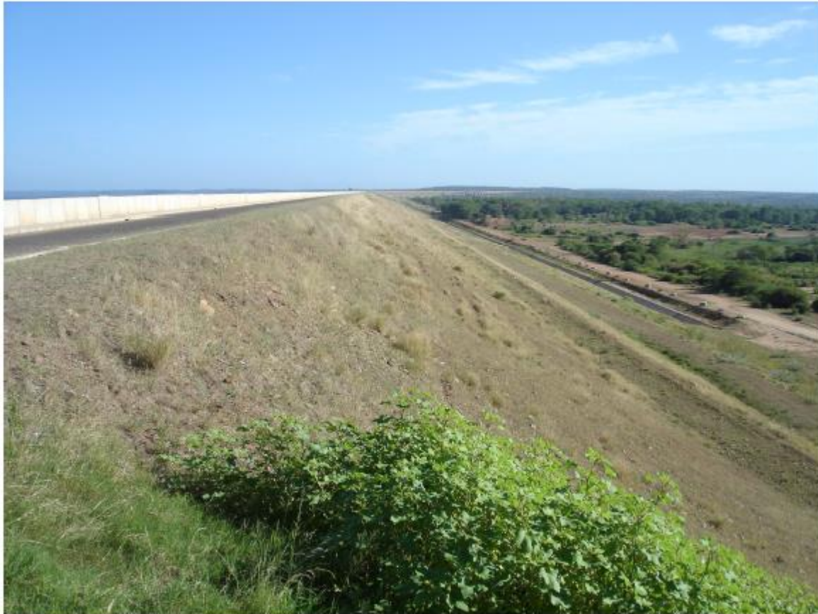
Anexo 12 - Aspecto geral do talude de jusante do dique da margem direita (vista para a margem direita)
