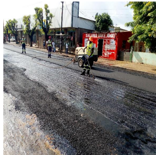
Figura 12: limpeza da água com compressor para posterior aplicação do betão asfáltico
