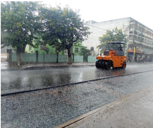
Figura 11: trabalho de compactação com tempo chuvoso
