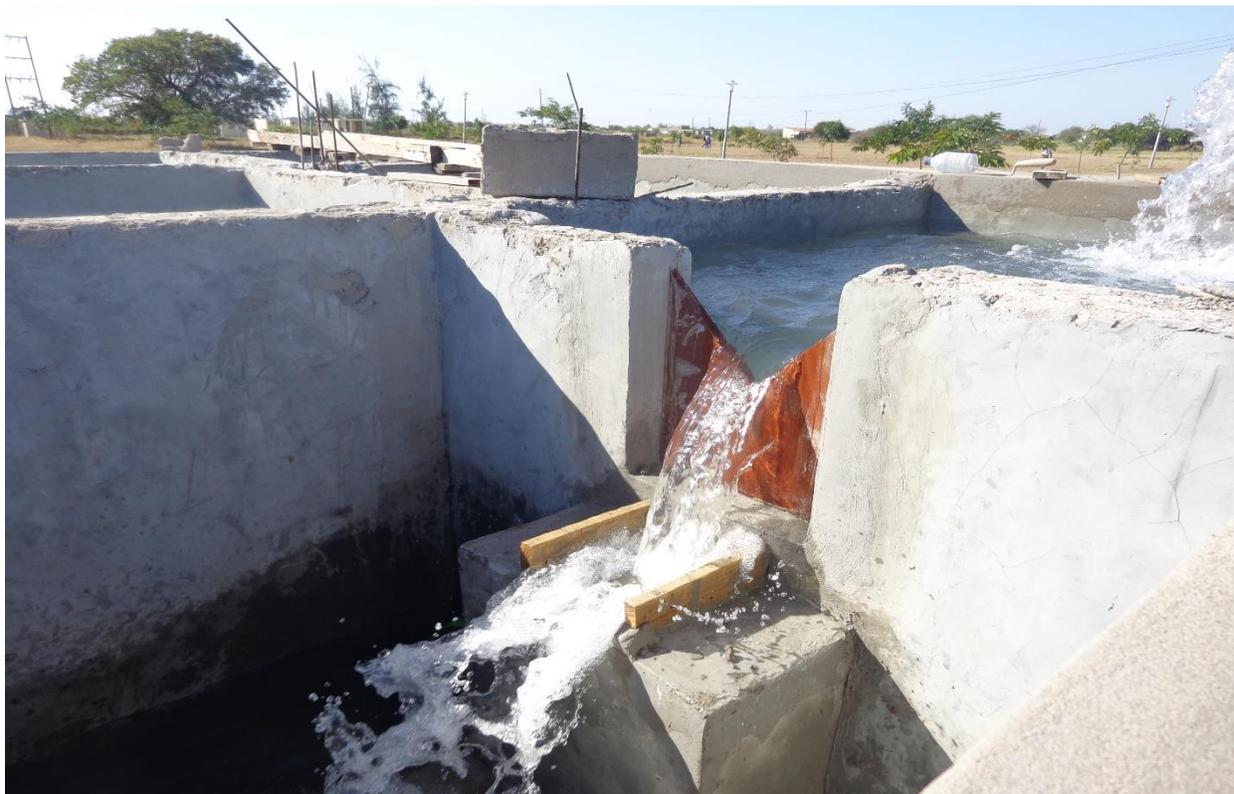
Figura 10: Vertedor triangular em operação
