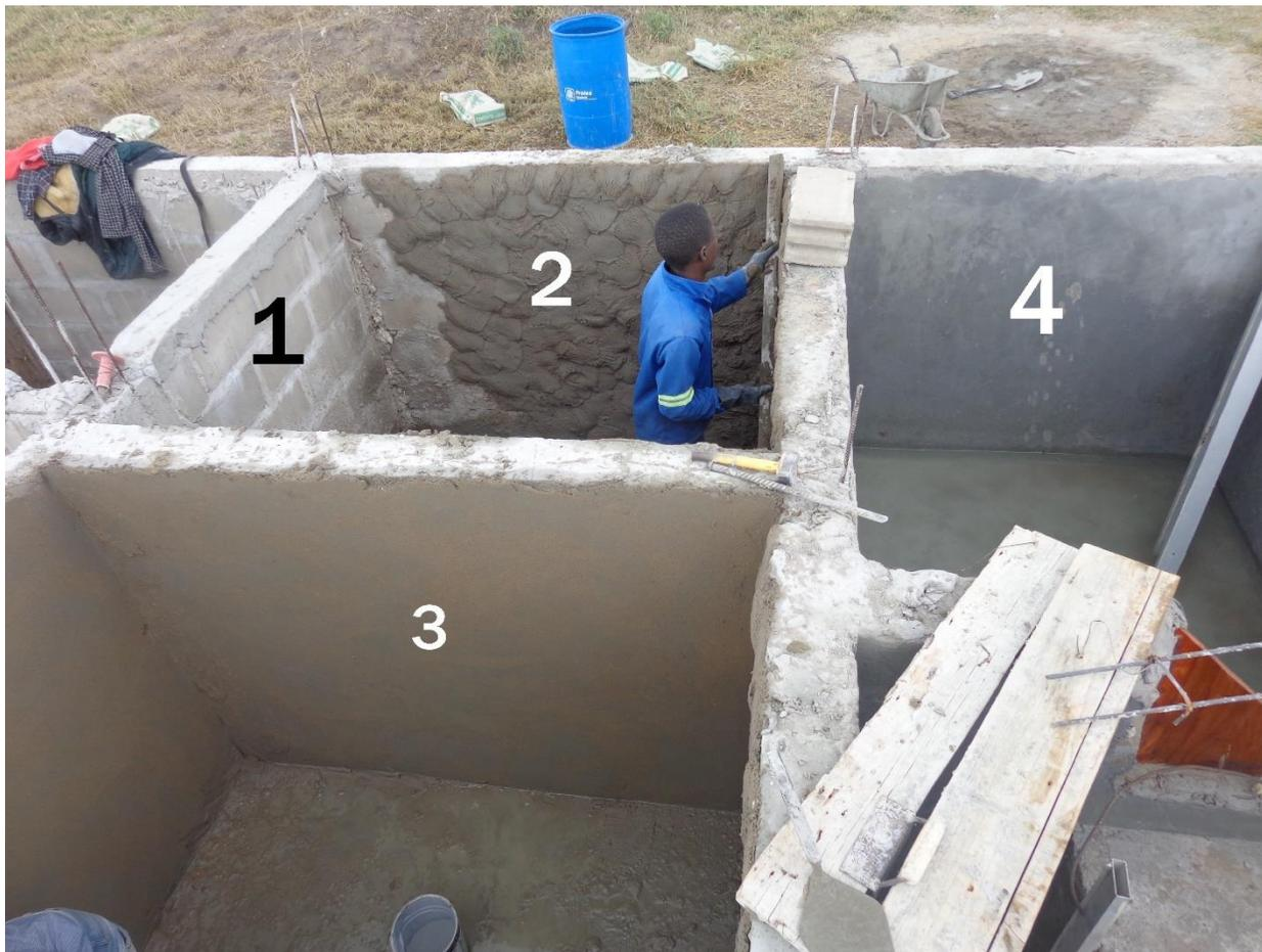
Figura 9: Reboco e impermeabilização das paredes internas da estrutura
