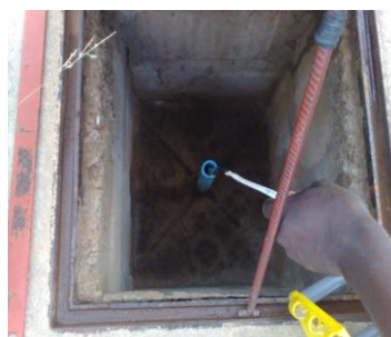
Figura 16: Verificação da carga hidráulica
