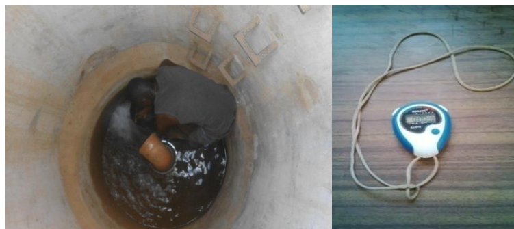
Figura 14: Medição da vazão dos poços de alívio
