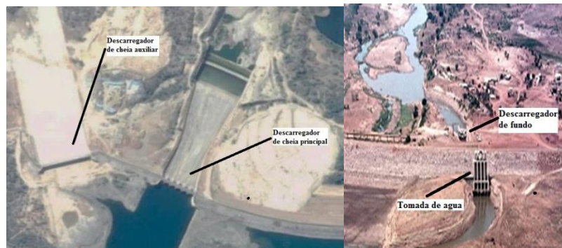
Figura 11: Órgãos hidráulicos da barragem de Massingir (Marcelino, 2012)
