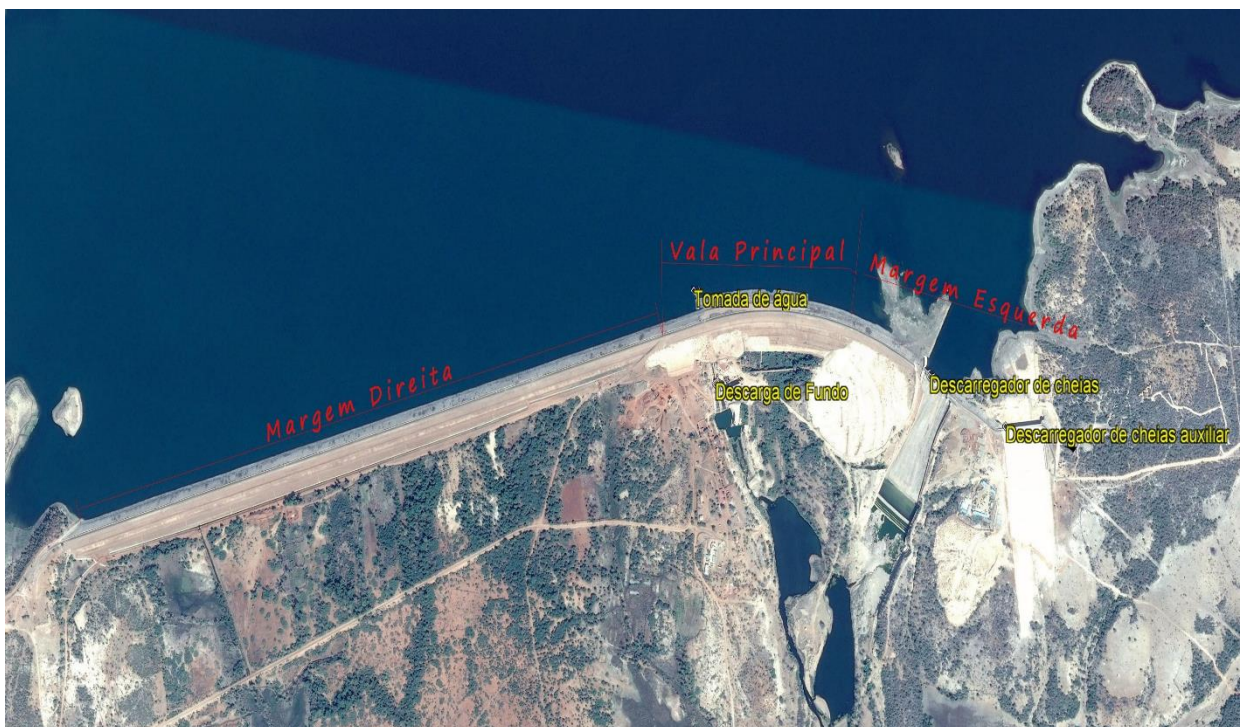
Figura 4. Barragem de Massingir
