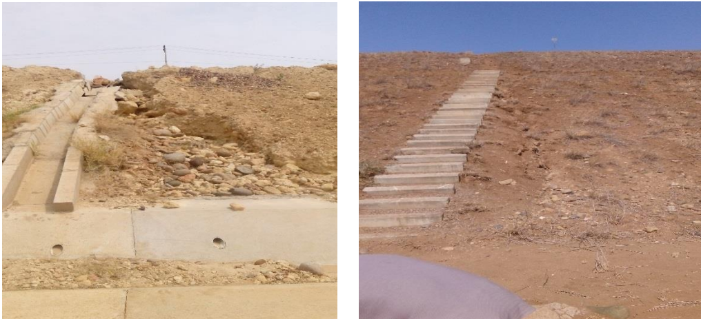
Figura 2. Obstrução da vala principal e das caleiras devido a precipitação e criação de caminhos preferenciais da água na superfície dos taludes
