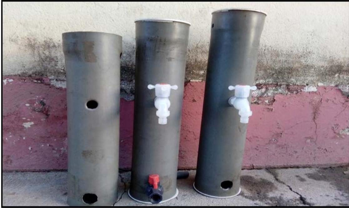
Figura 9: Fase construtiva do modelo de tanques sépticos, destaque para abertura dos furos e colocação das tapas
