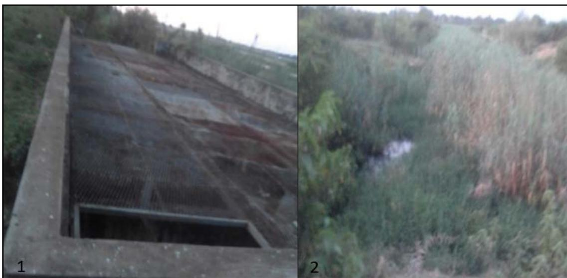
Figura 5: (1) Ponto de coleta de composto por caixa de areia e o sistema de gradeamento em fluxo vertical e (2) Ponto de lançamento de esgoto a qual faz parte da vala de drenagem
