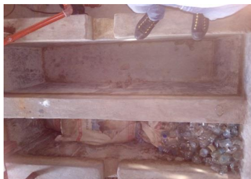
Figura 2. Limpeza de tanque
