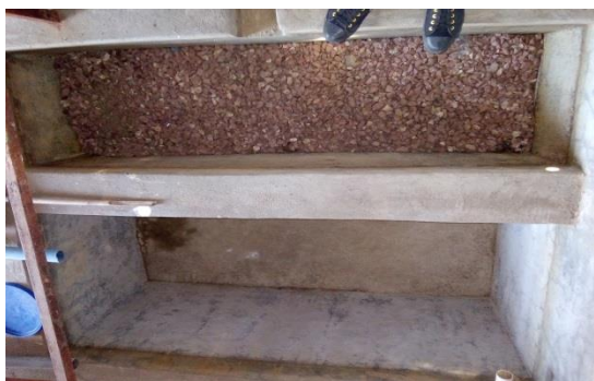
Figura 1. Limpeza de tanque
