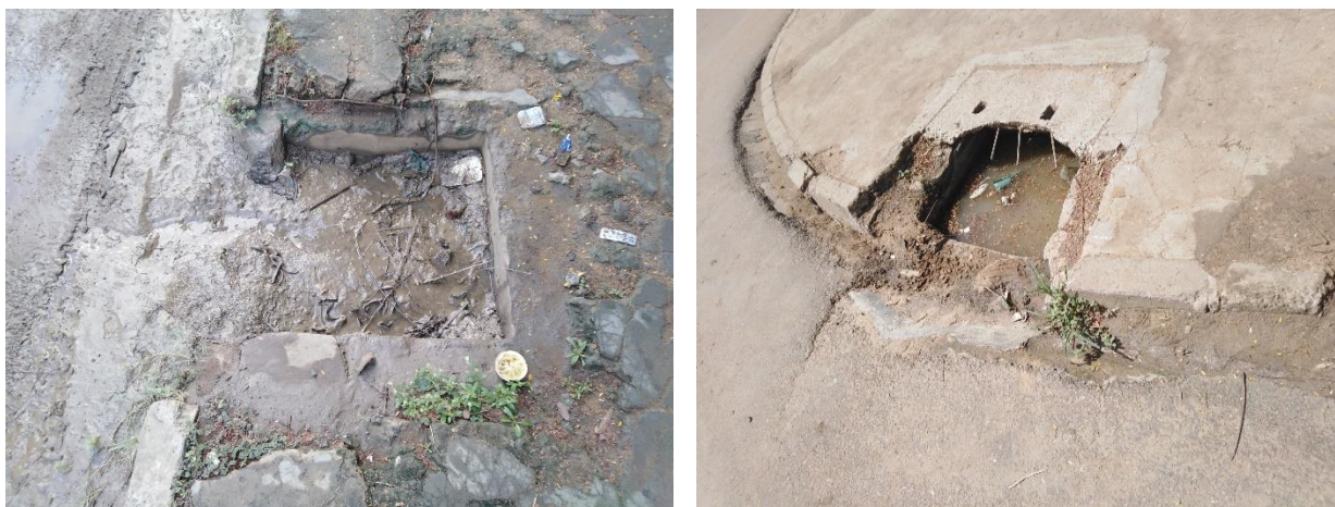
Figura 6. Estado de alguns sumidouros de guia 19h após a precipitação a) e b) .
