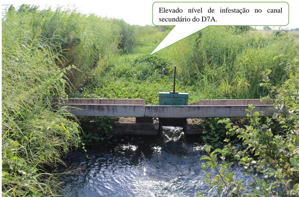
Figura 21: Estado actual (elevado nível de infestação) no canal secundário do D7A.
