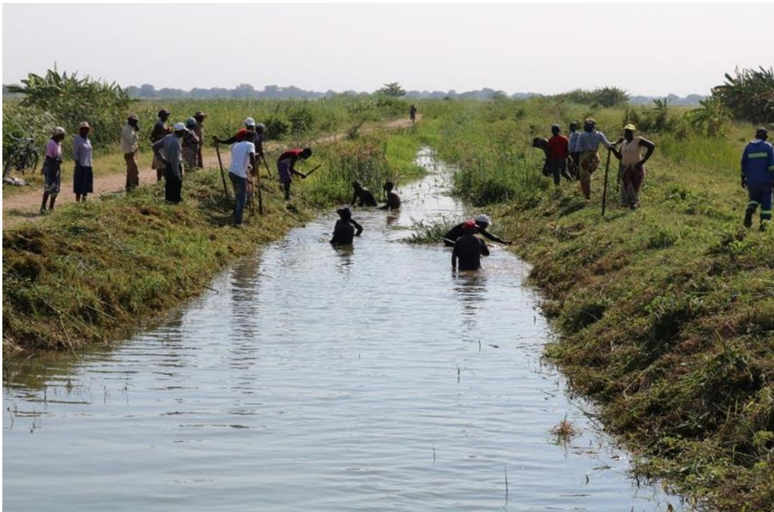
Figura 13: Operações das limpezas de forma manual no canal secundário do D7
