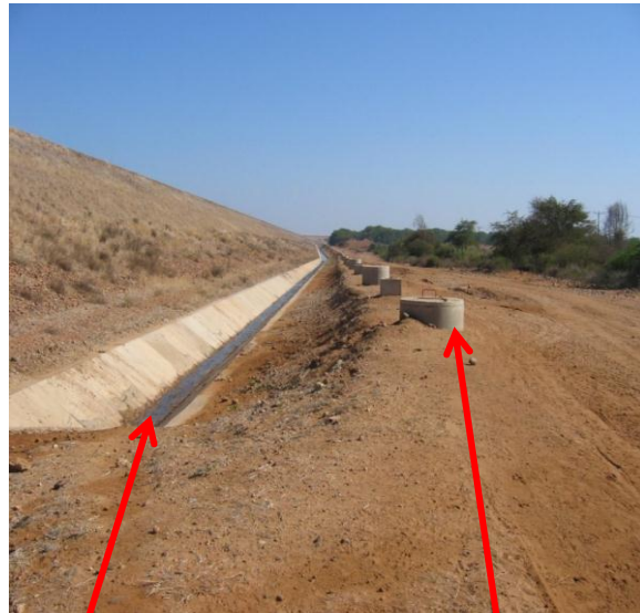
Vala de betão, Poços de alívios
