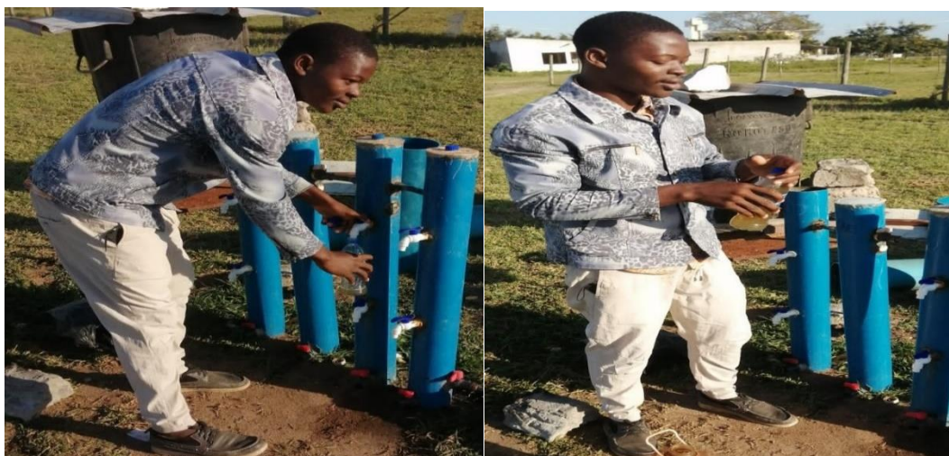
Figura 14: Ilustra ponto de colecta do dejetto tratado nos reactores UASB.
