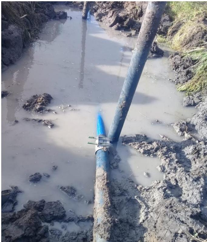
Fig.: 2 – Fuga Aflorante em regiões
