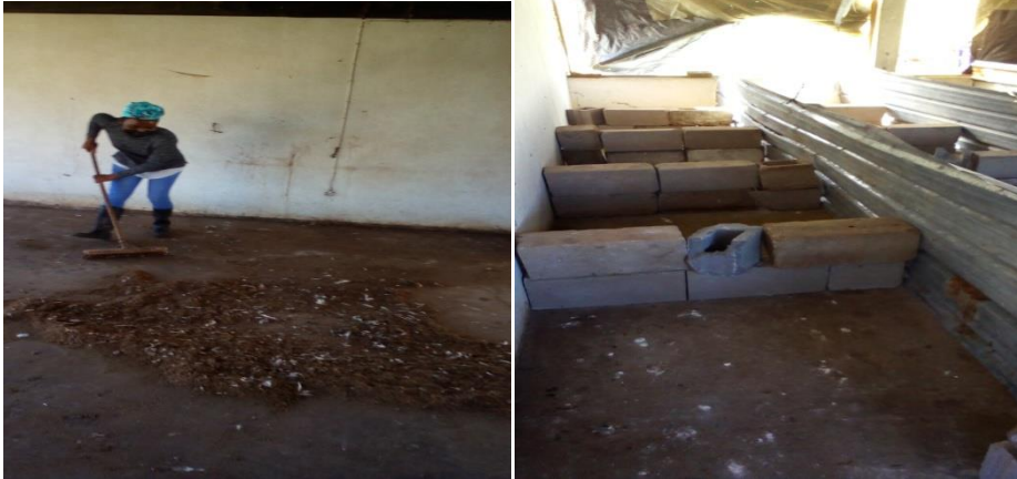
Fig 1: Limpeza no local Fig 2: Divisão dos compartimentos
