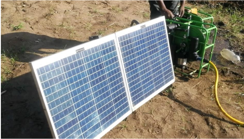
Figura 2: Conjunto painéis solares e bomba.
